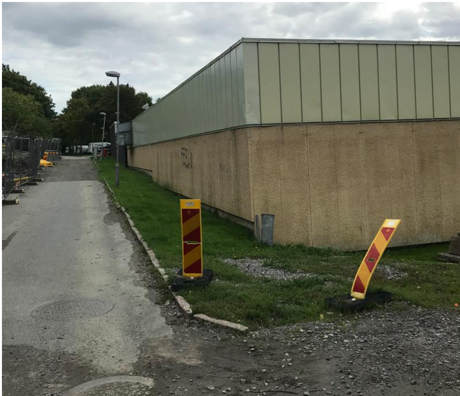
Figur 13. Bild från platsbesök (2023.09.21).
