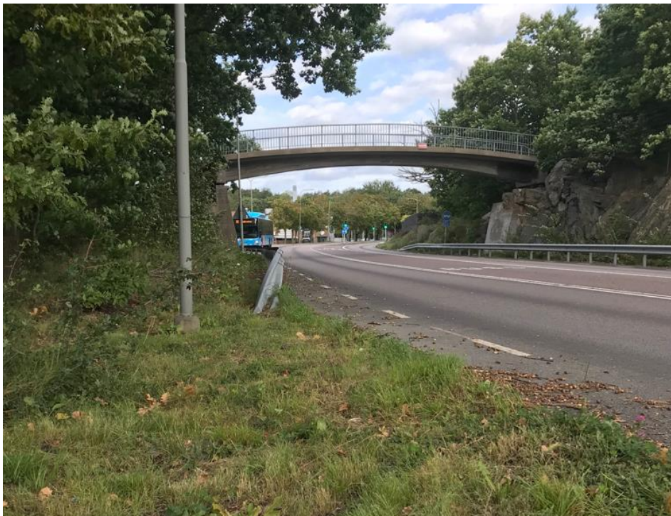
Figur 10. Bild från platsbesök (2023.09.21).
